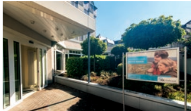
Haupteingang der IKK-Geschäftsstelle in Trier.
